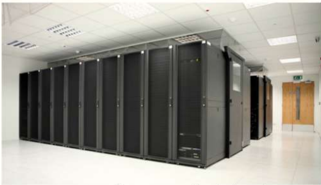
ภาพการติดตั้ง Ducted HACs ในดาต้าเซ็นเตอร์
